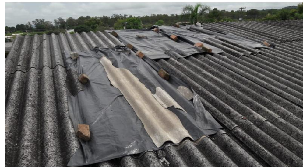
Legenda: Foto externa da cobertura na área xxxx. Data: xx/xx/25.
